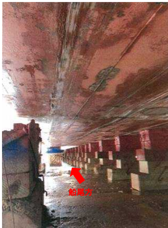
写真2 本船の損傷状況（船底部）
