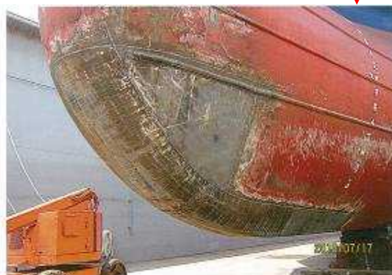
写真2 修理状況②
