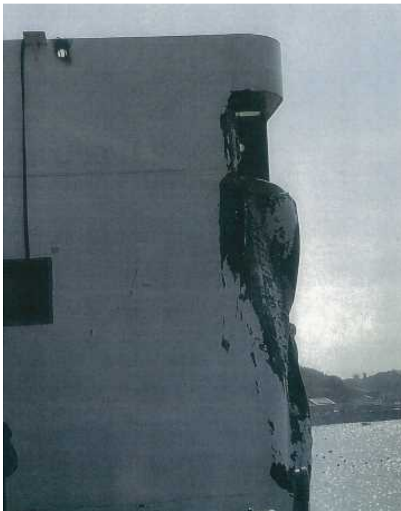
写真5 B船の損傷状況（船橋構造物左舷側）
