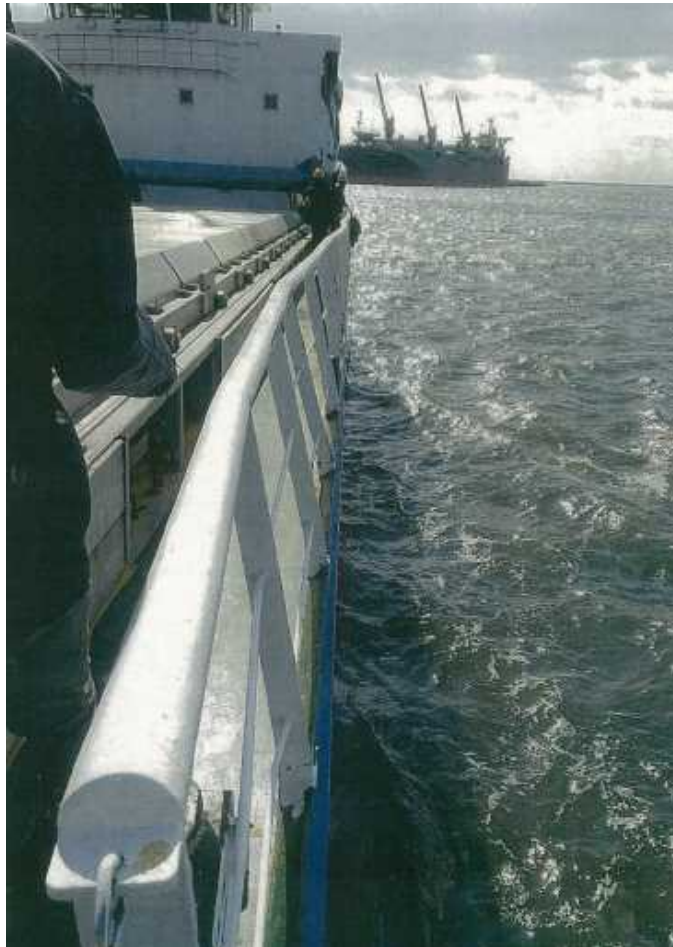
写真4 B船の損傷状況（左舷外板）
