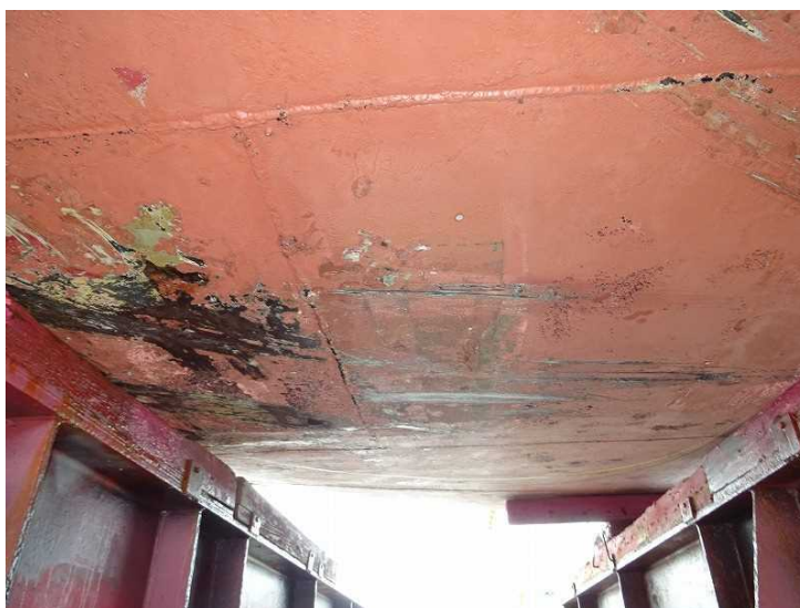
写真4 A船船底損傷状況
