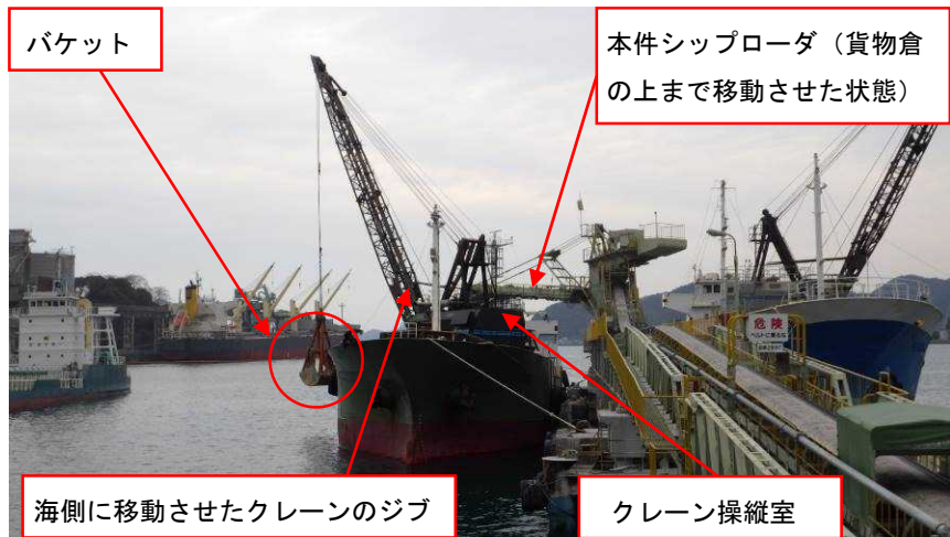
写真1 積み荷役中の本船と本件シップローダの状況
