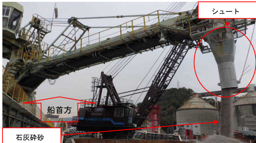
写真2 本船の積み荷役状況
