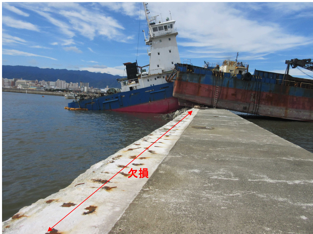
写真3 乗揚状況及び防波堤の損傷状況
