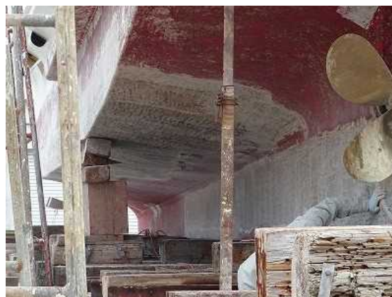
写真2 左舷船底の修理状況
