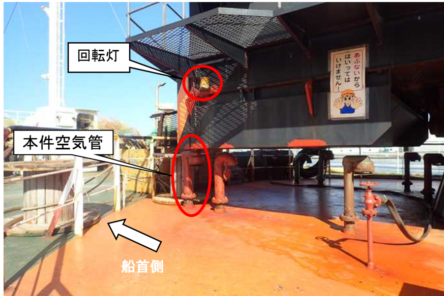
写真3 本件クレーン機械室と本件空気管（船首側）
