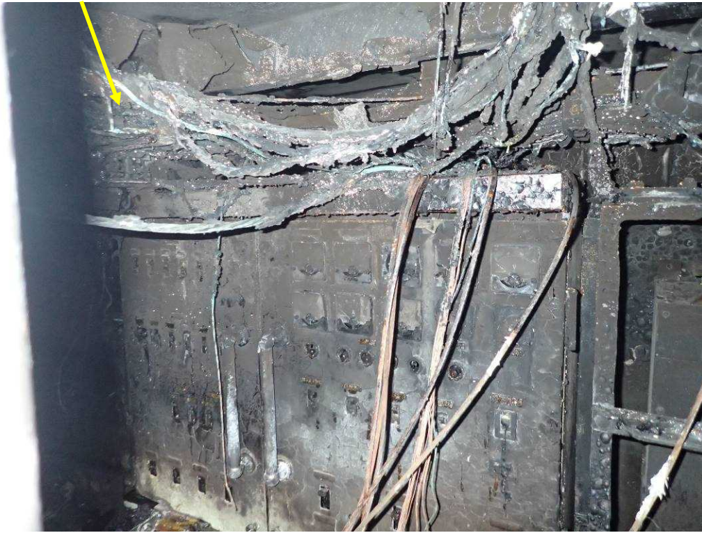
写真3 配電盤焼損状況
