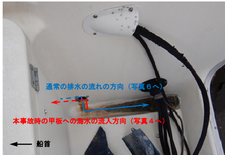
写真5 船尾外板の放水口の状況（右舷内側）（同型船）
