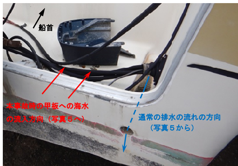
写真6 船尾外板の放水口の状況（右舷外側）（同型船）
