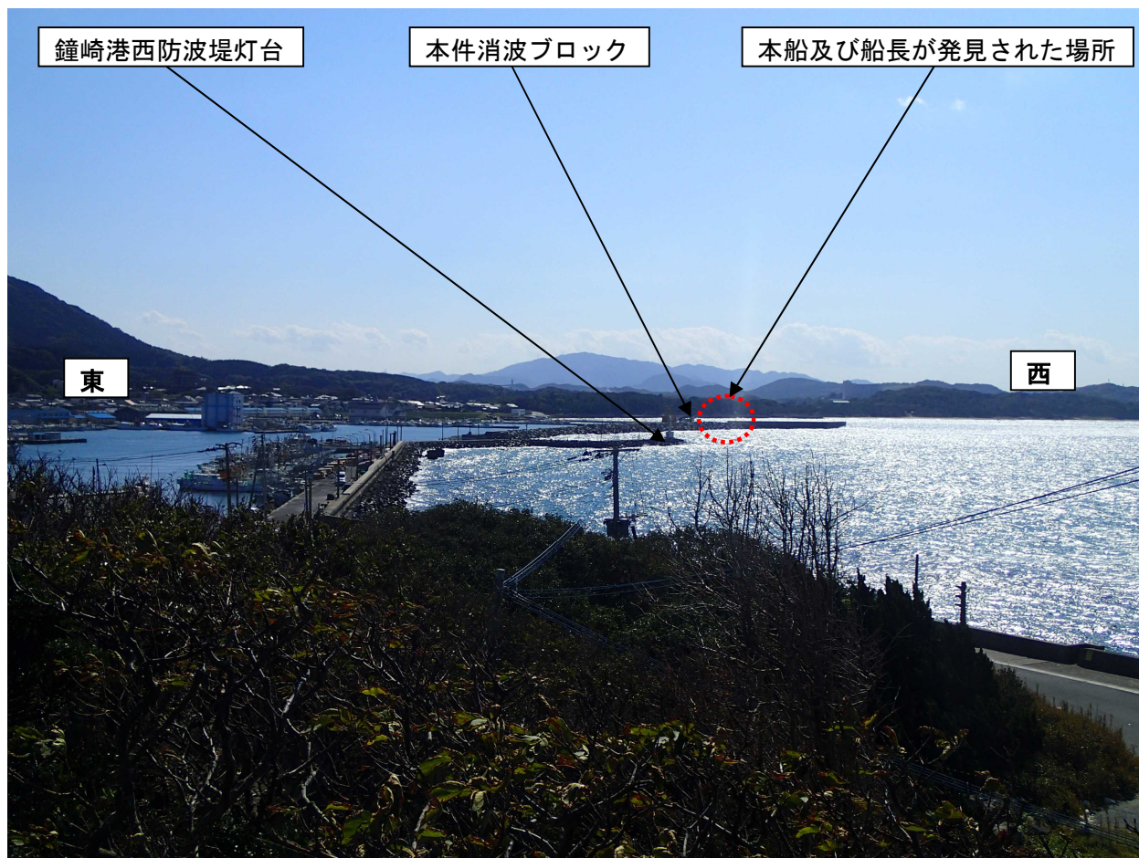
写真1 本件消波ブロック
