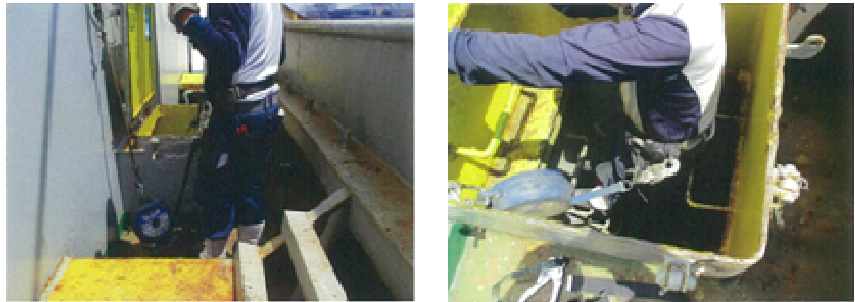
写真3 落下防止用具の使用例
