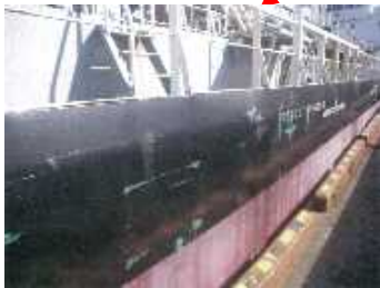
写真1 A船の損傷状況①
