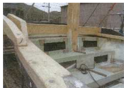
写真7 B船の修理状況②
