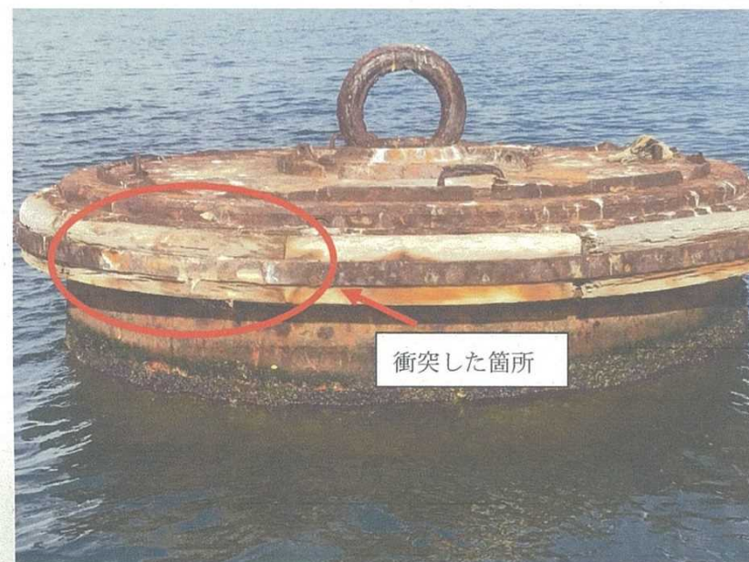
写真4 本件浮標の損傷状況
