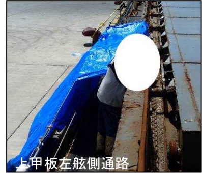
写真2 シートを張る作業
