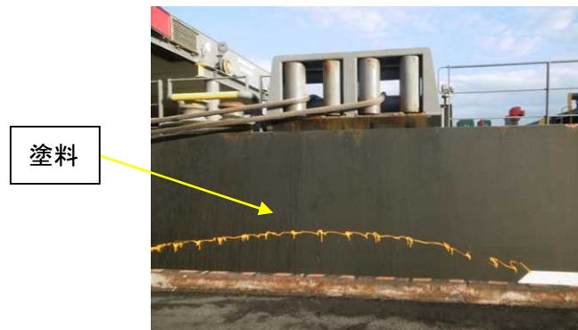
写真3 本船の左舷中央部外板の船尾寄りの状況
