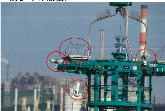
写真4 本件灯浮標の損傷状況 (マーキング装置及び太陽電池パネル 鳥よけの破損)
