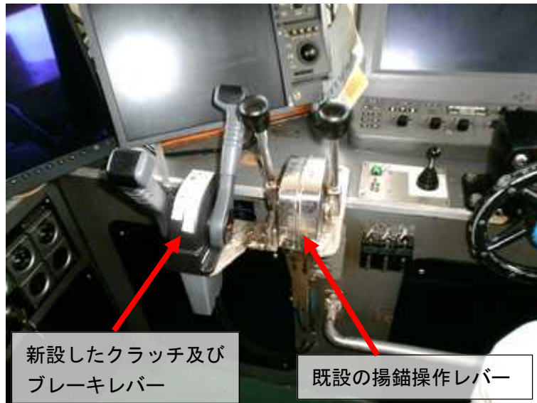
写真4 改良工事後の操舵室内揚錨機操作レバー
