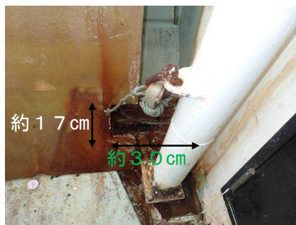
写真5 左舷船尾側から2個目の放水口
