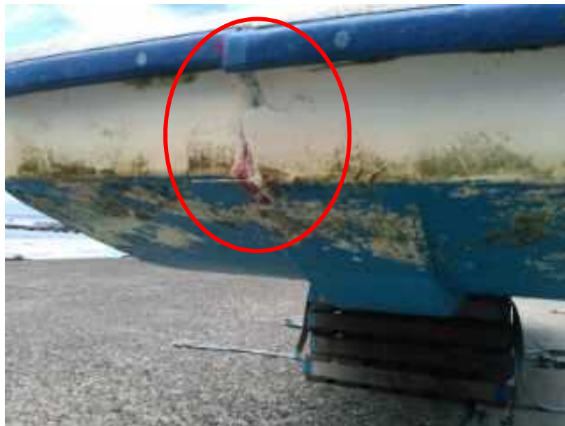
写真4 B船の損傷状況（船首部）
