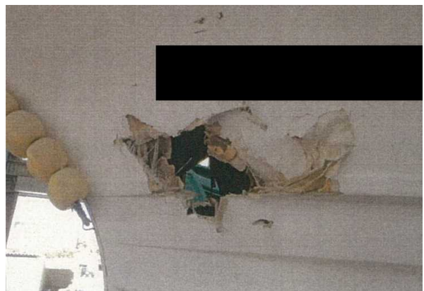
写真4 A船の損傷状況②
