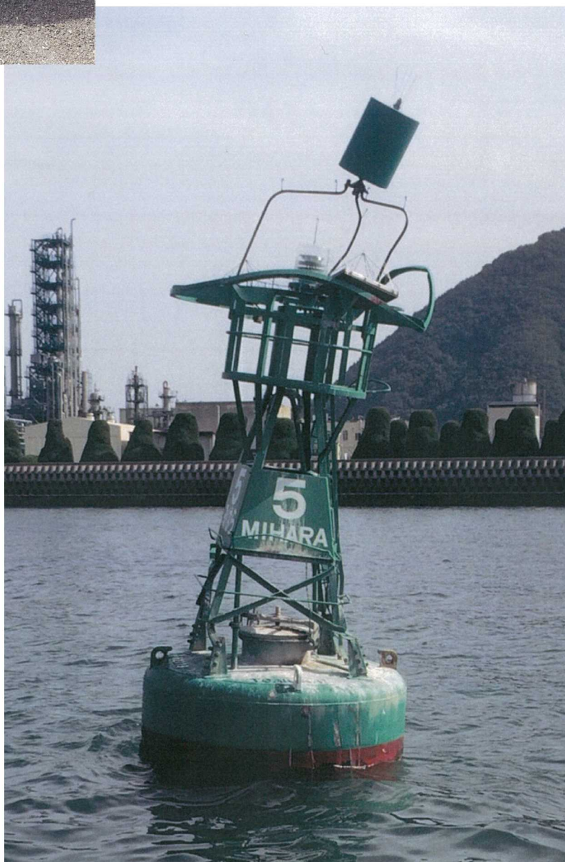
写真2 本件灯浮標の損傷状況
