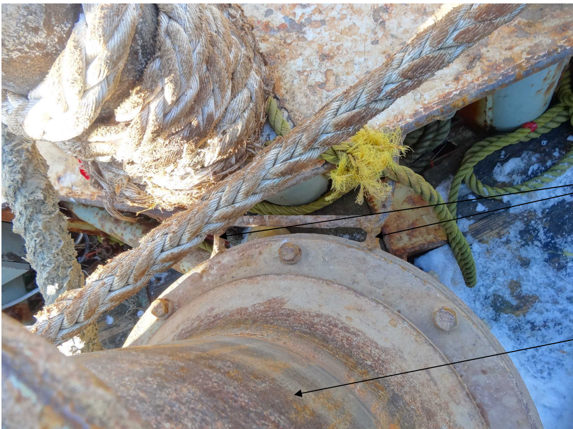
写真2 キャプスタン及び溶接箇所
