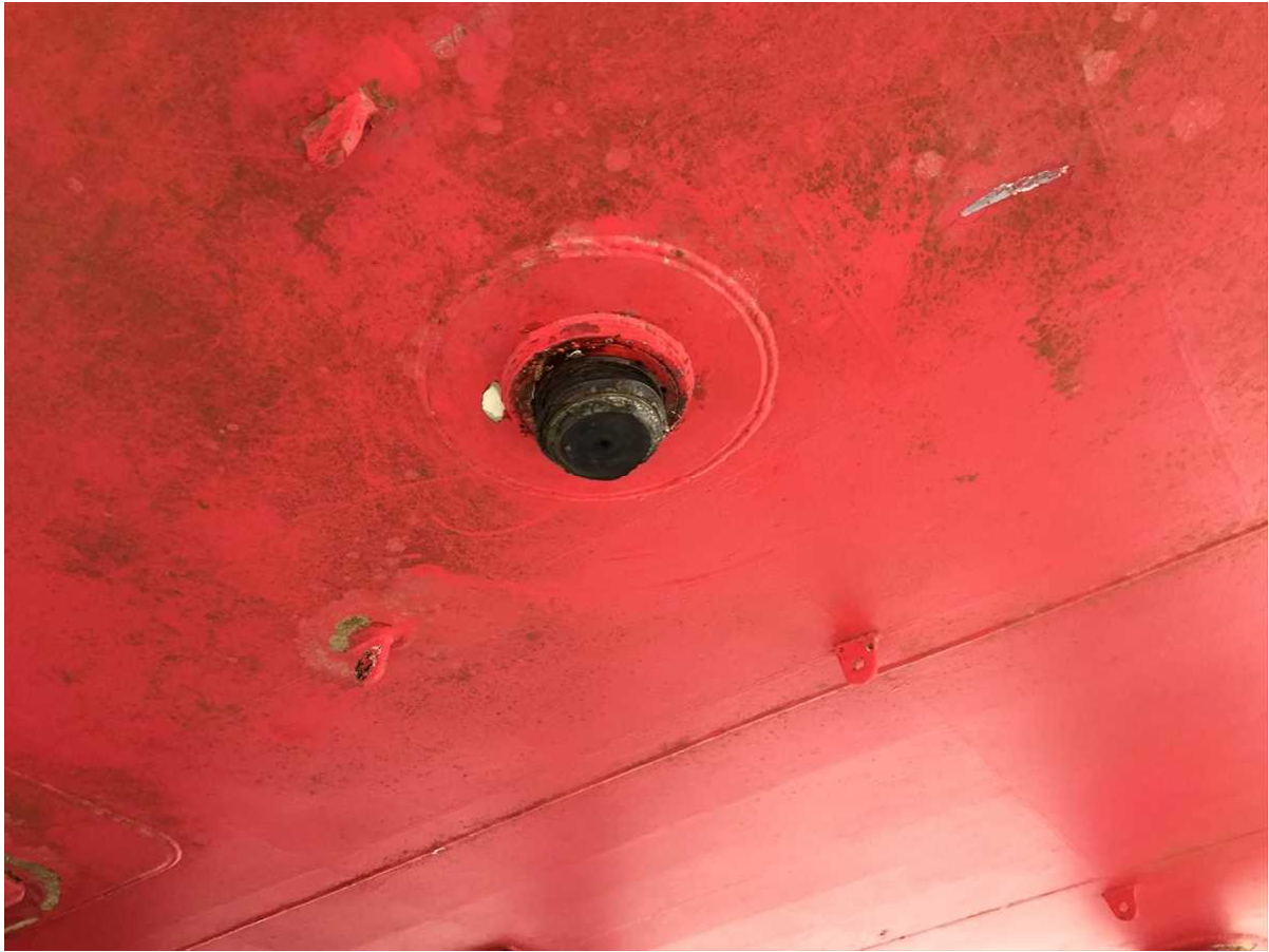
写真3 左舷舵板脱落部
