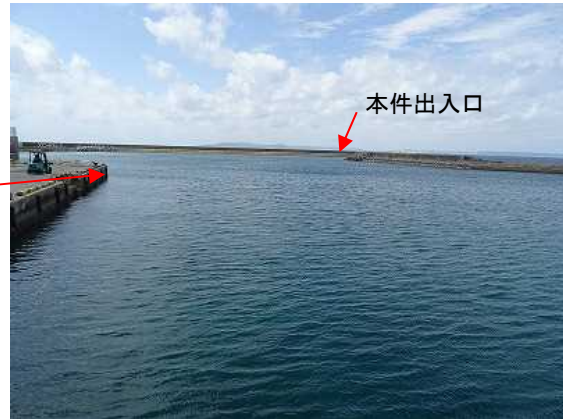
写真2 津堅地区の港内状況
