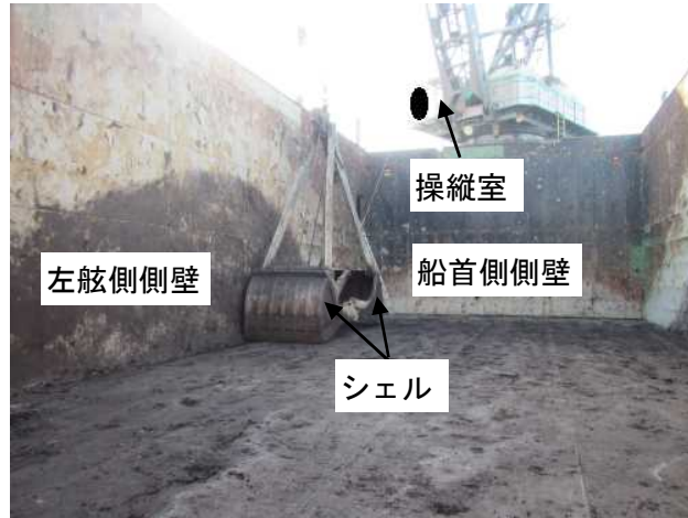
写真1 グリースの注入作業開始時の船倉内の状況 （船尾側床部より）
