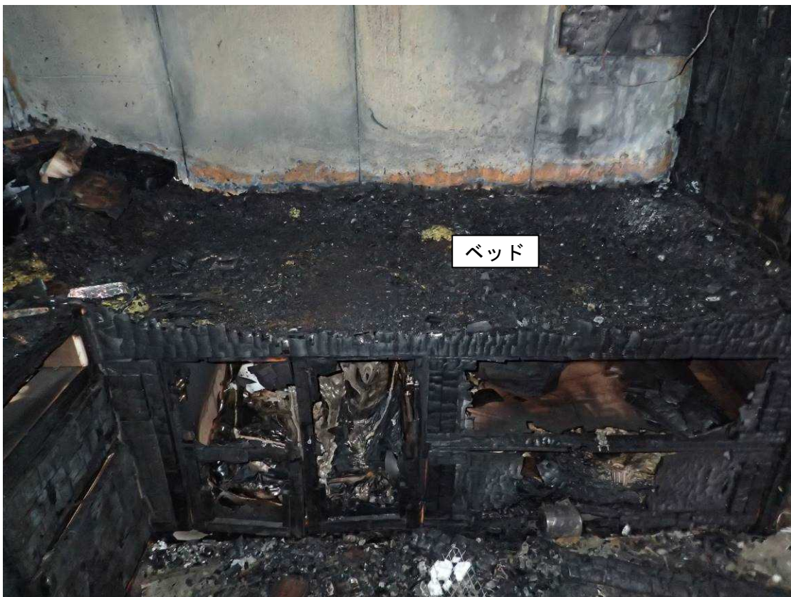
写真2 機関長室内（右舷側）
