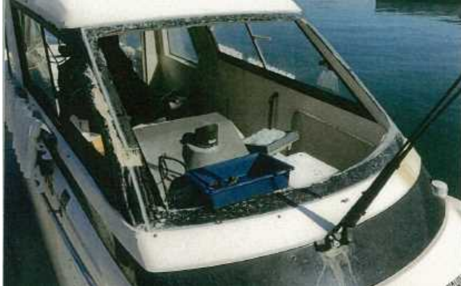
写真6 B船操舵室損傷状況
