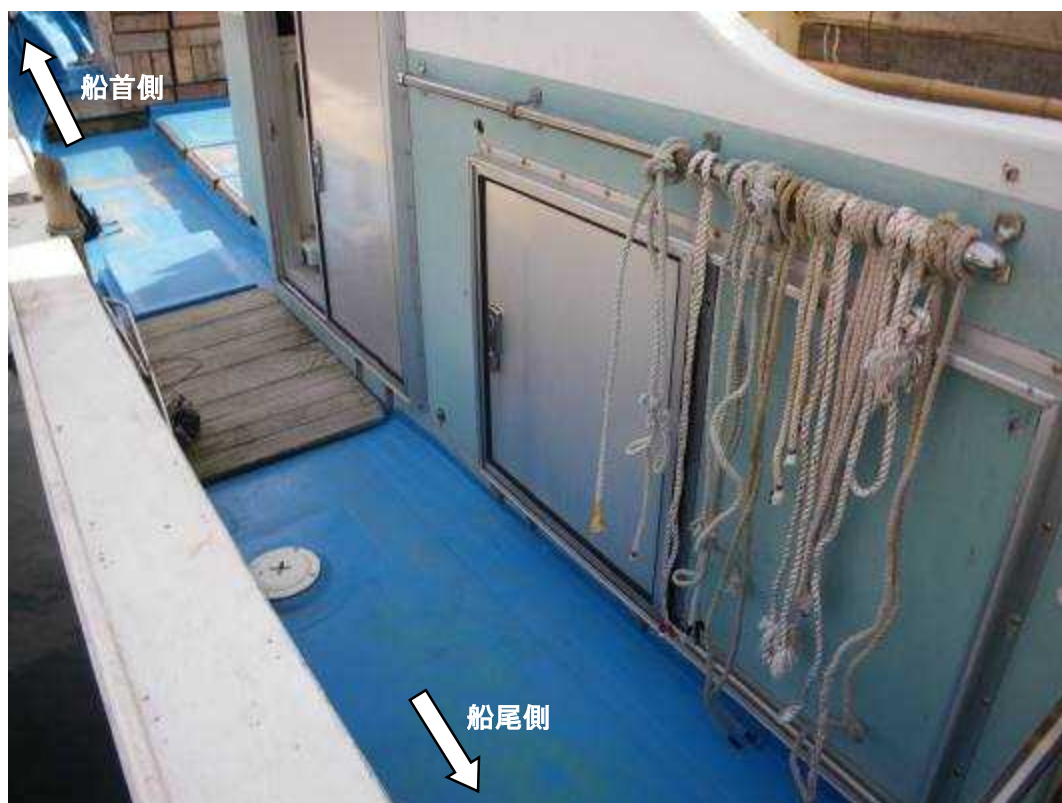
写真2 機関室の出入口
