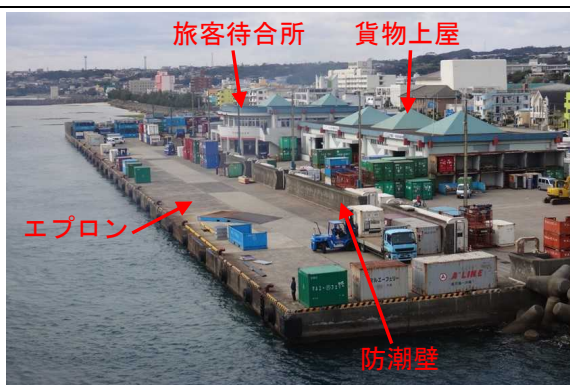
写真3 亀徳港の-9m岸壁
