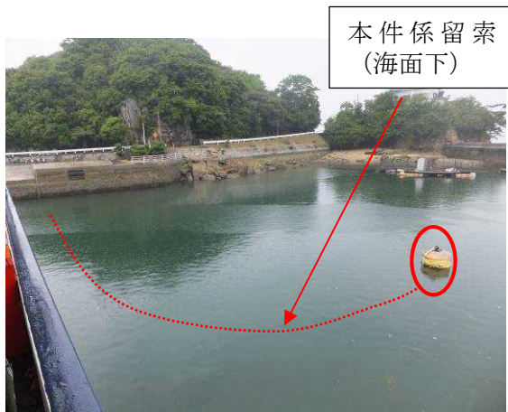
写真13 本件フェリー岸壁付近の状況
