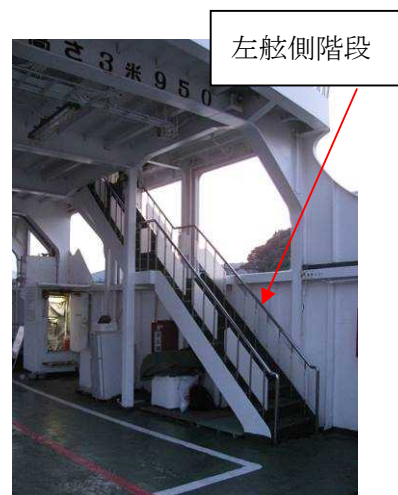
写真8 左舷側階段の全景
