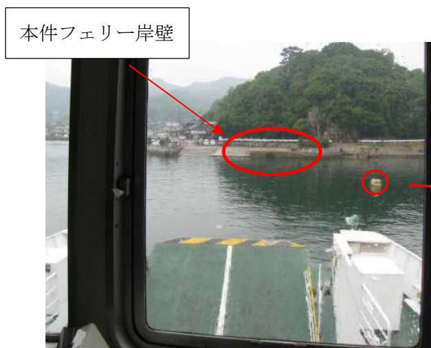
写真11 本件フェリー岸壁
