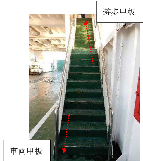
写真10 左舷側階段（拡大）
