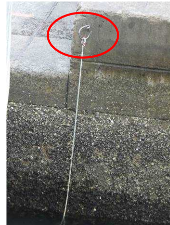
写真14 鋼製リングと本件係留索に接続した細索（事故後、5月24日撮影）
