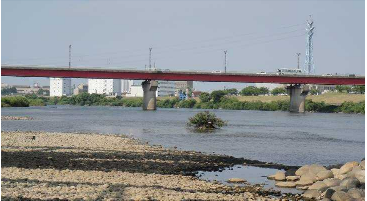
写真5 富山北大橋付近
