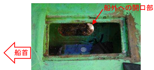
写真8 右舷側の前部放水口内
