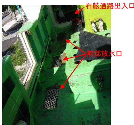
写真6 右舷側の前部放水口
