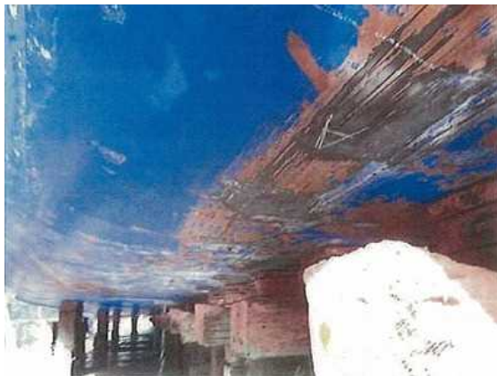
写真3 船底外板の損傷
