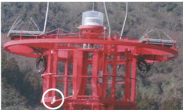
写真5 本件灯浮標の損傷状況（防護枠下部の曲損）
