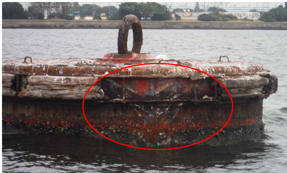
写真2 本件浮標の損傷状況
