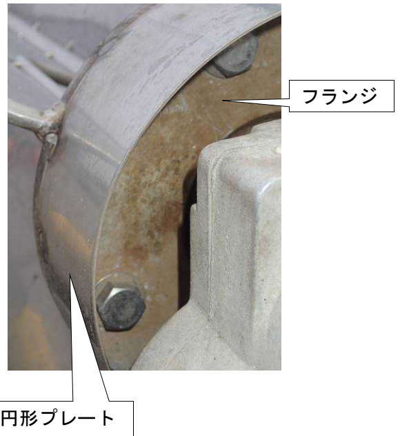
写真6 本件ローラの取付けボルト
