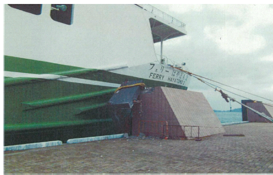
写真2 防衝工及び同固定土台
