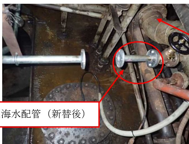
写真4 海洋生物付着防止装置の海水系統
