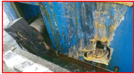
写真 2.3-2 A船の左舷船首部外板の 破口状況（A社提供）
