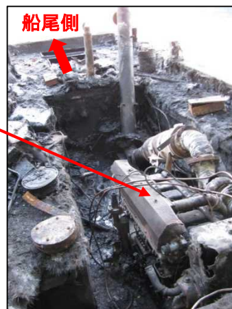
写真4 焼損状況 (機関室②)
