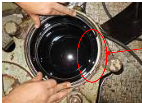
写真6 主機潤滑油供給管内で発見されたこし器蓋部のリングの状況
