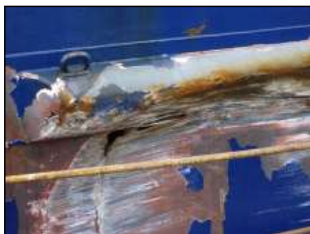
写真2 応急修理中の損傷箇所 (右舷中央部)
