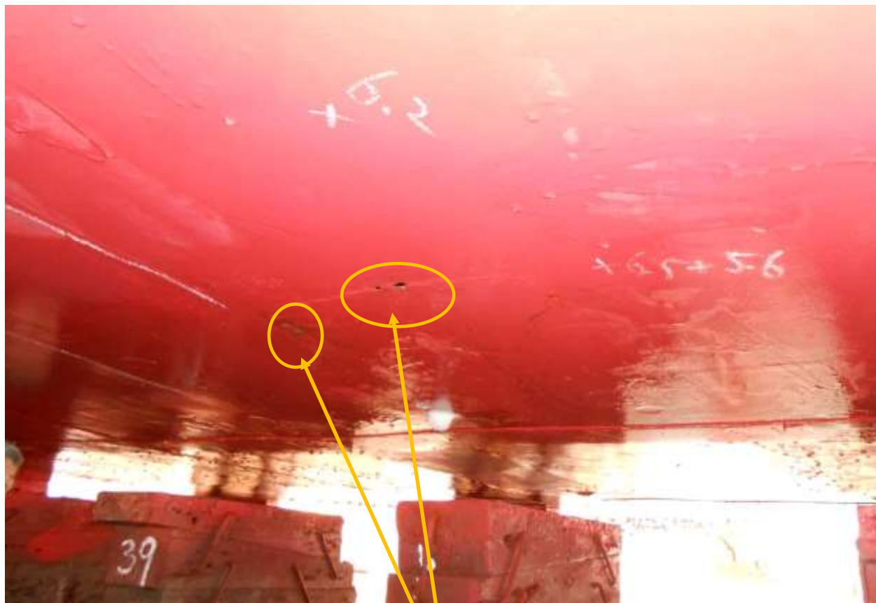
写真1 船底外板の破口
