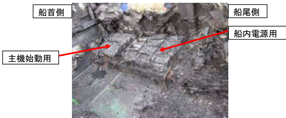
写真3 バッテリーの焼損状況
