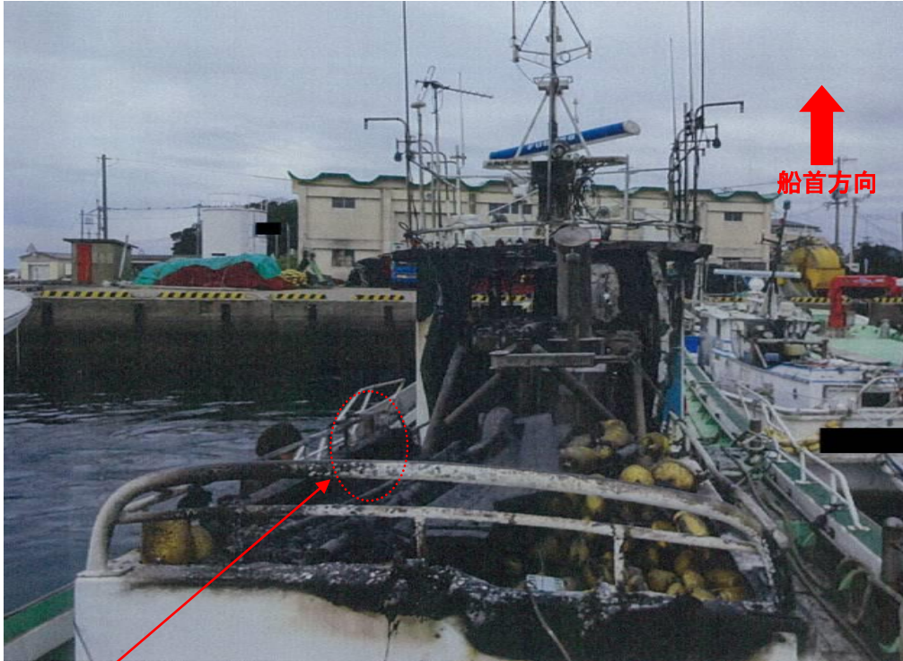
写真1 本船の焼損状況
