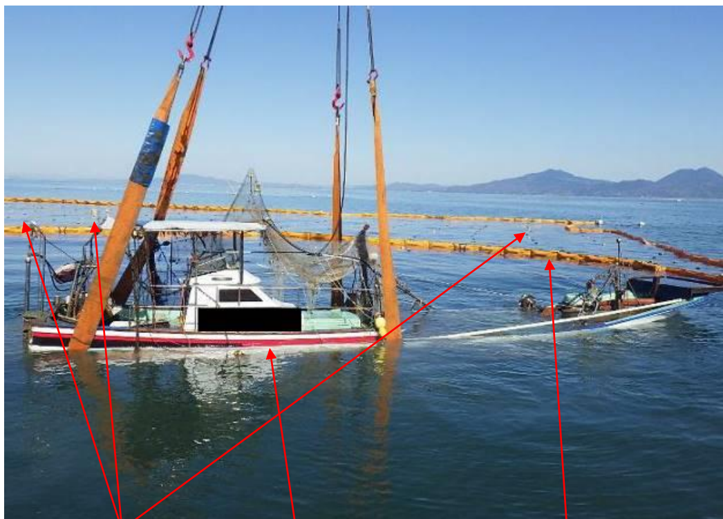
写真1 本船の引揚げ状況
