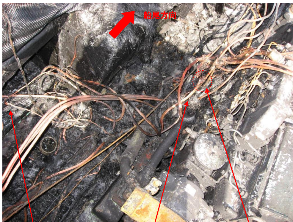
写真3 バッテリから主機の始動機に至る電気配線の状況
