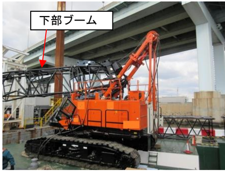
写真1 本件クレーン（左側から）
