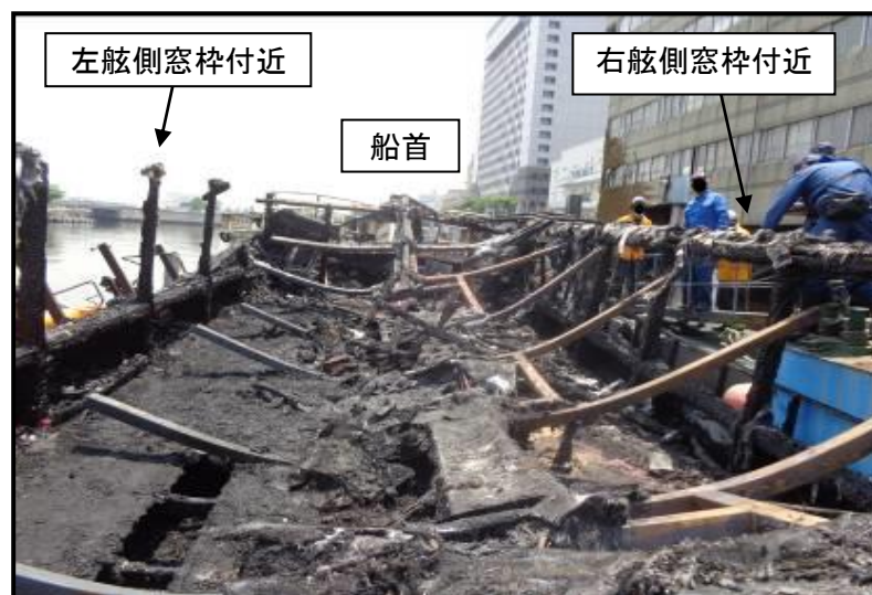
写真2 本船の焼損状況（客室船尾方より）
